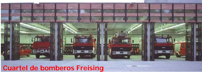
Cuartel de bomberos Freising
