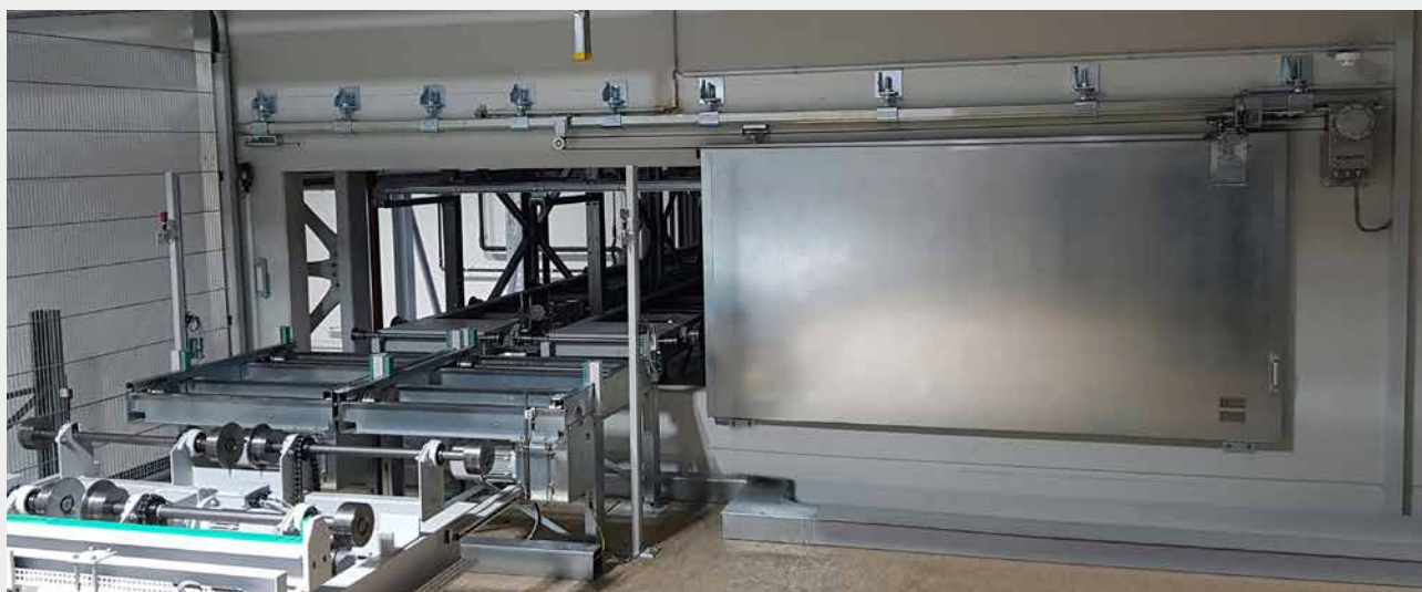
Cloisonnement d'un entrepôt à système de rayonnage en hauteur
