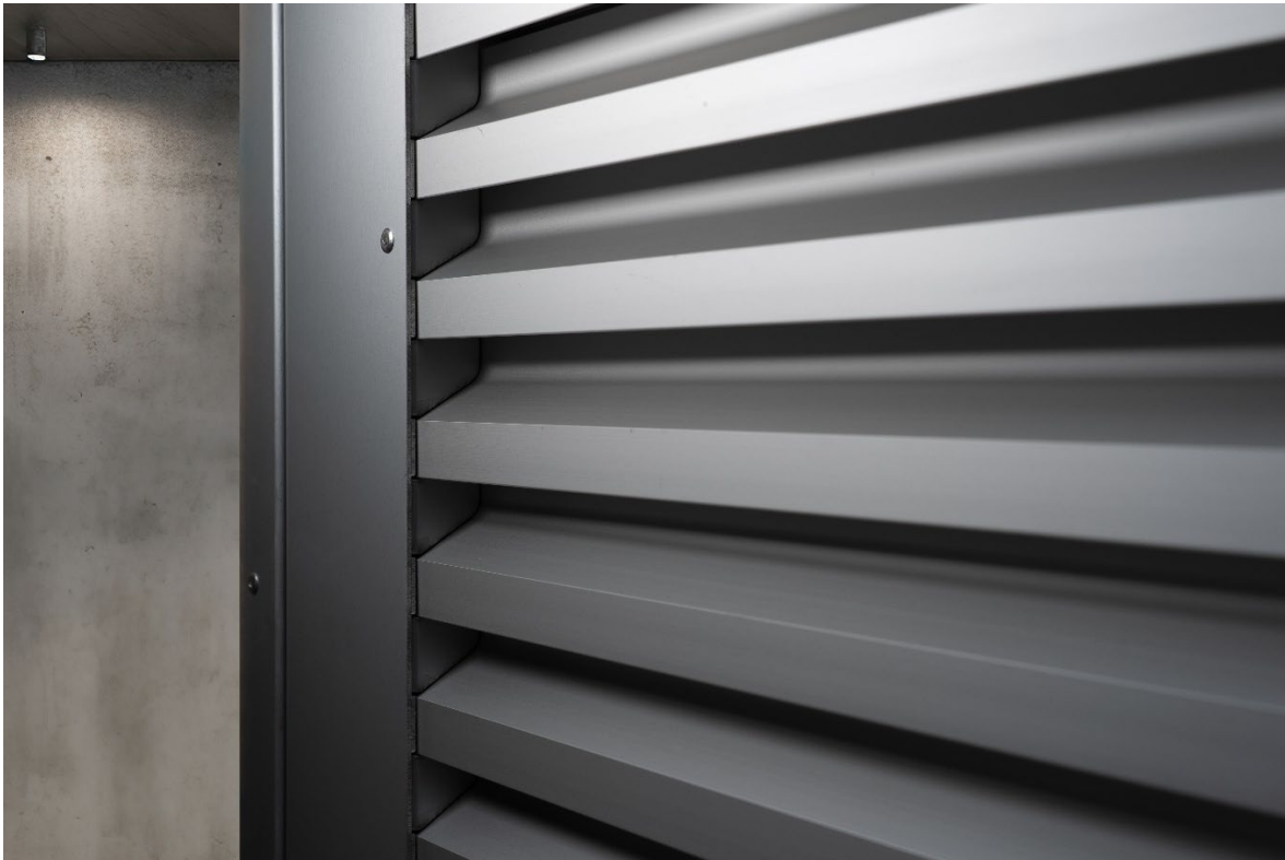
Bild 2: Optimierte Lamellengeometrie ermöglicht verbessertem Lüftungsquerschnitt
