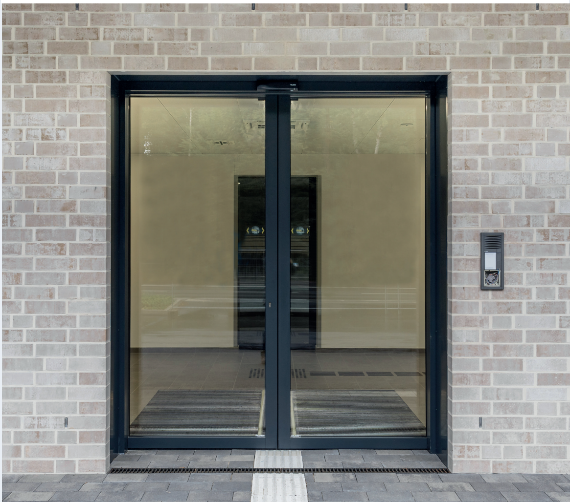
Vollautomatisierte Sicherheitsschiebetür
