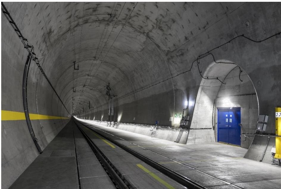
600 Türen und Tore von Hodapp kommen bei Stuttgart 21 und die Schnellfahrstrecke Wendlingen-Ulm zum Einsatz. Foto: Nikolay Kazakov
