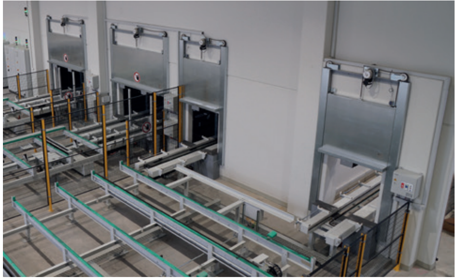
Anlage Brandschutztore, Hörmann KG Werk Leipzig
