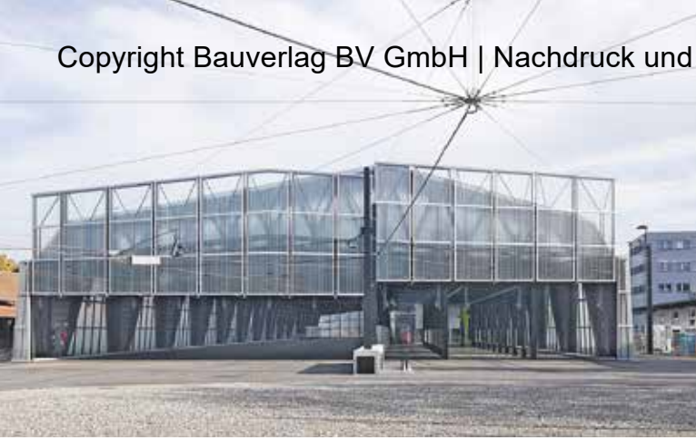
Dank der sich vertikal bewegenden Torflügel ergaben sich zusätzliche Tramabstellplätze. Diese Raumnutzung hatte die Bauherren überzeugt.
