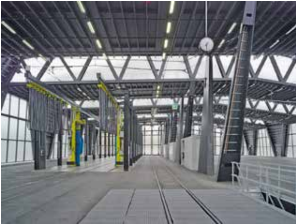
Die erste Großgarage für Trams in Bern hatte bereits die Fläche von zwei Fußballfeldern, aktuell wird sie nochmals erweitert.
