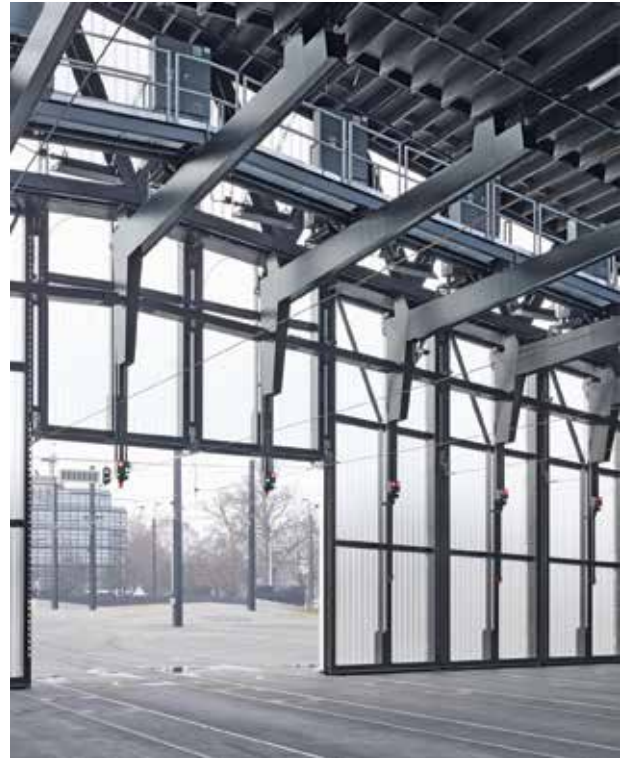
Eine technische wie statische Herausforderung für Hodapp: Die Fassade der Ein- und Ausfahrten durfte keine Stützen beinhalten.
